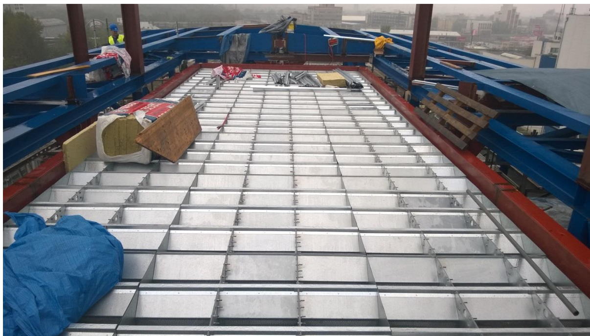
Montáž nosného rámu.
