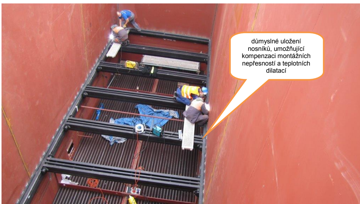
Montáž nosného rámu.
