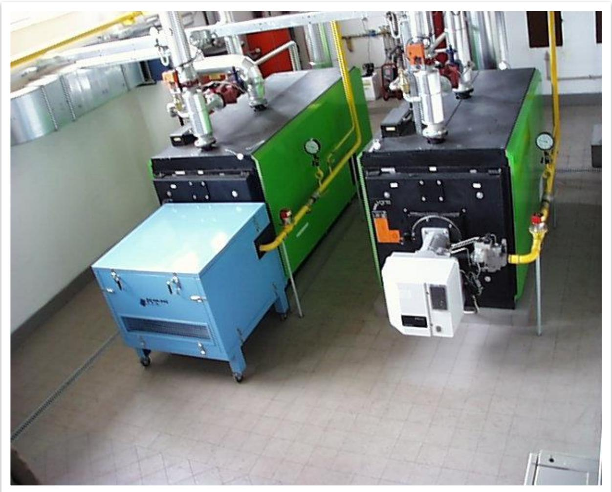
Kryty jsou projektovány dle požadavků na útlum hluku, tlakovou ztrátu a typ kotle.
