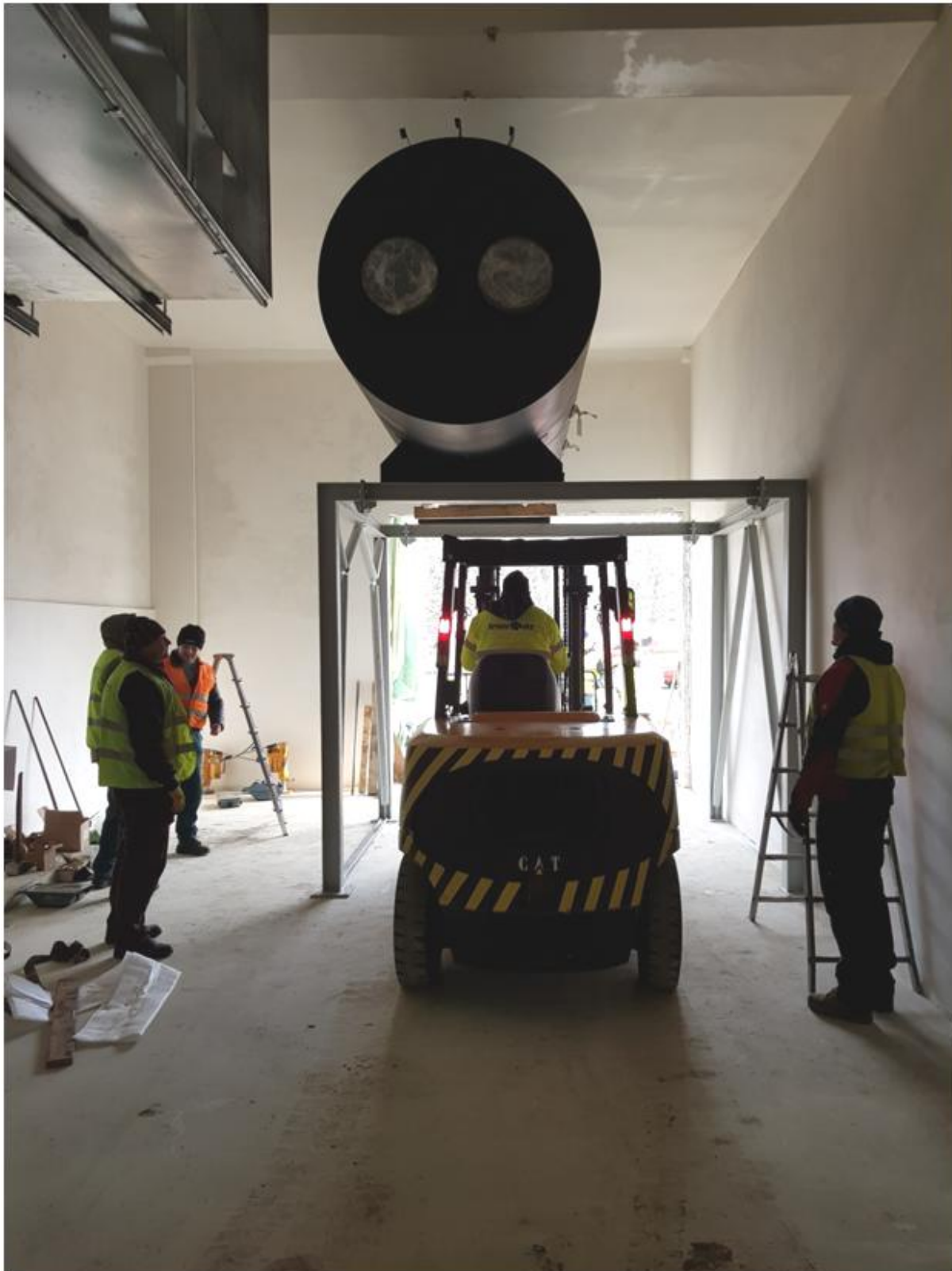
Obr. 6C – Instalace tlumiče hluku na ocelovou konstrukci:
