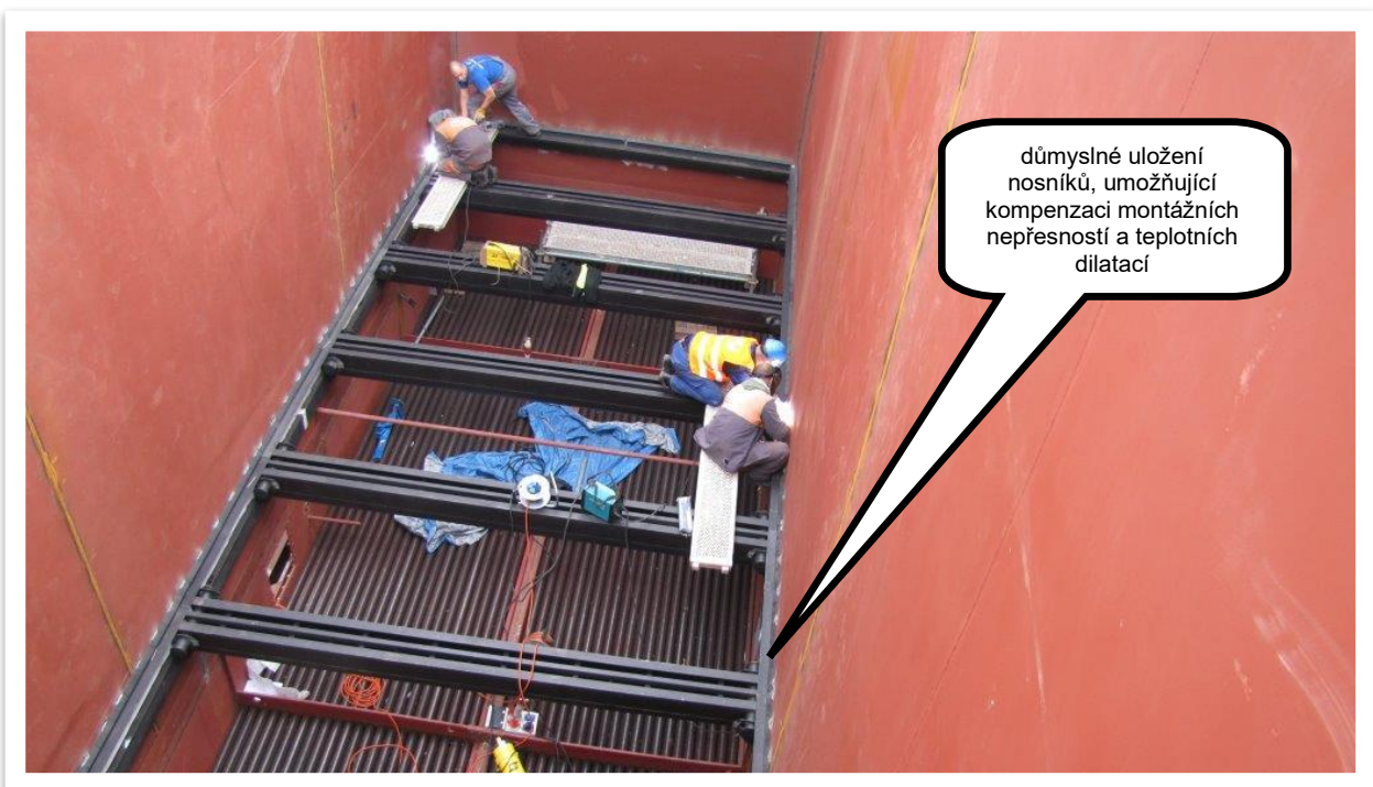
Montáž nosného rámu.
